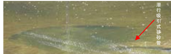
写真-3 土砂吸引状況
