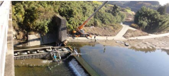
写真-1 実験装置全景（実験中の状況）
