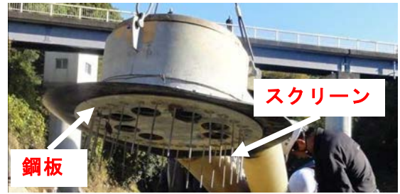
写真-2 管径200mm管吸引部
