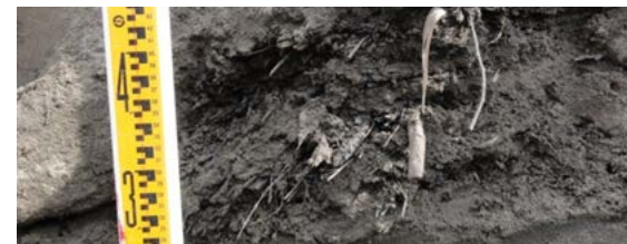
写真-4 吸引を阻害した塵芥層
