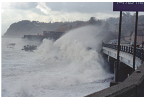
写真-4 北陸沿岸部の道路橋の厳しい塩分環境
