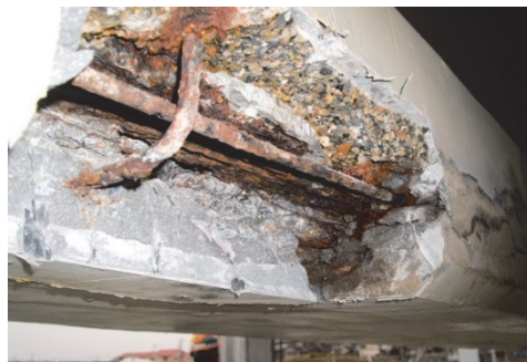
写真-1 道路橋の塩害による著しい損傷事例 (再劣化のはつり調査時の状況)
