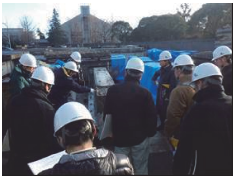
写真-3 土木研究所での撤去部材の確認状況 (平成27年度、1年目の研修)
