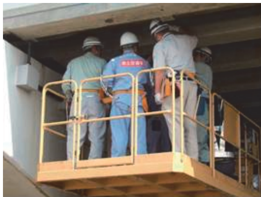
写真-5 弁天大橋での現場実習状況
