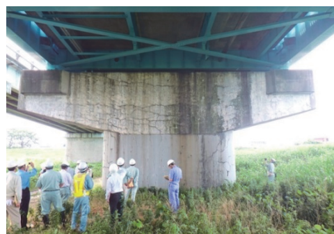
写真-2 道路橋のASRによる著しい損傷事例
