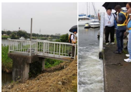
写真-5 樋門 (左)、水位観測標尺 (右)
