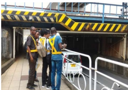
写真-4 避難上問題となる箇所
