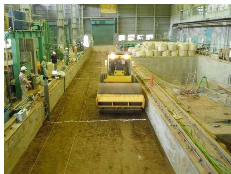
写真-1 転圧状況
