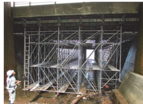
写真-13 支保工設置状況
