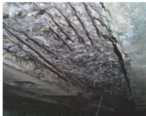
写真-12 PC鋼材破断状況
