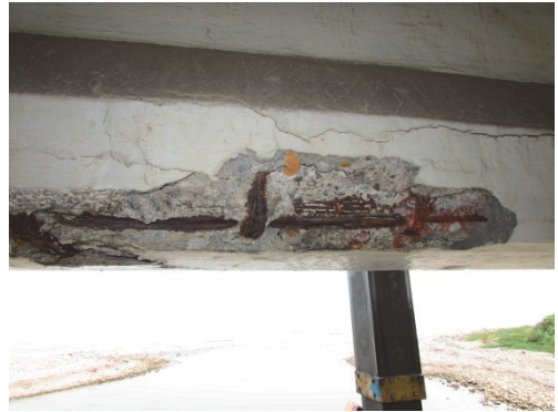
写真-2 塩害によるPC鋼材の破断
