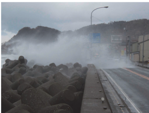
写真-1 日本海の荒波を受ける国道8号の状況
