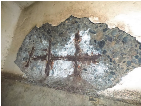
写真-10 電気防食範囲外の損傷
