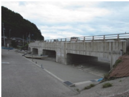
写真-4 函渠化した両鬼橋
