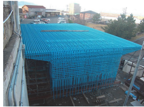
写真-7 筒石橋の鉄筋の仮組状況
