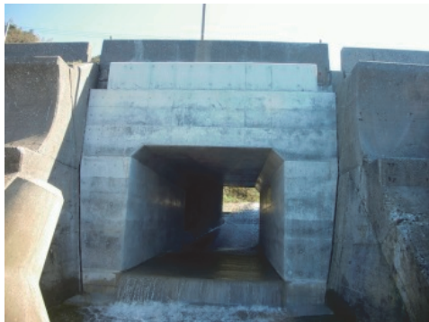
写真-16 函渠化後
