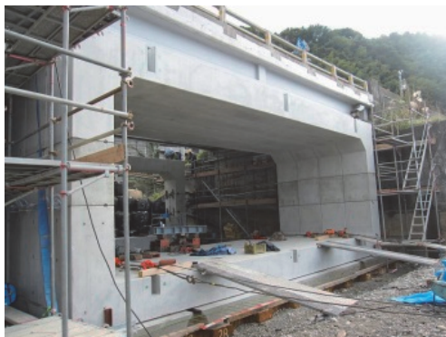
写真-5 両鬼橋のプレキャストBOXの引込み状況
