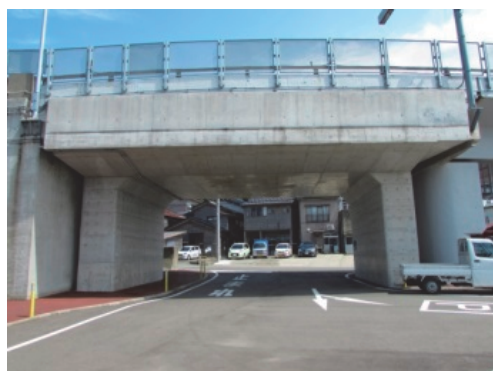
写真-6 函渠化した筒石橋
