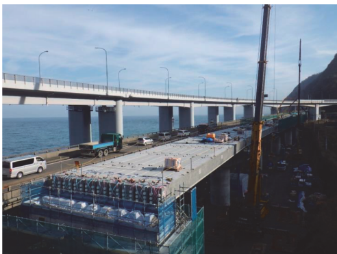
写真-3 桁架設中の歌高架橋
