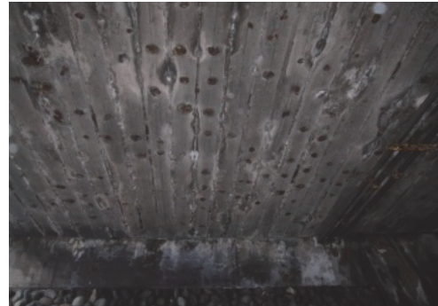
写真-11 下面変状
