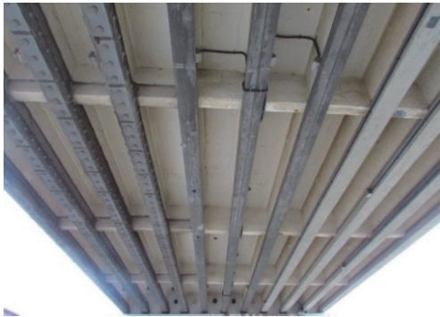
写真-9 弁天大橋電気防食設置状況
