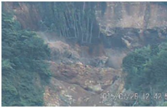
写真-3 5回目の土石流発生時 上流斜面部
