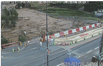
写真-5 6回目の土石流発生時 下流深港橋付近
