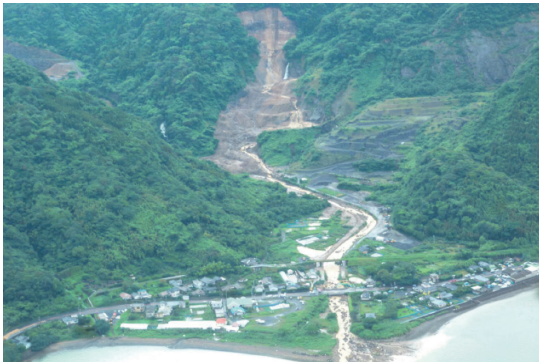
写真-1 被災直後の深港川（平成27.6.25撮影）
