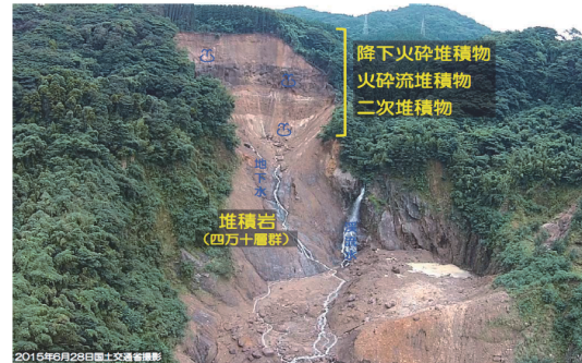
写真-2 崩壊斜面の地層 2)
