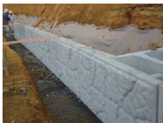
写真-3 最下段の箱体据付 図-8 各段の箱体設置
