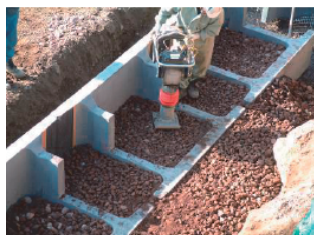
図-9 締固めの順 写真-4 充填材の締固め状況
