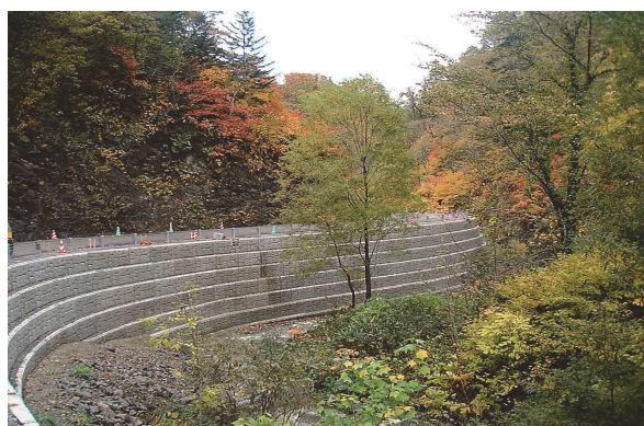
写真-1 路肩拡幅の施工例
