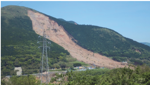
写真-1 南阿蘇村立野の大規模な斜面崩壊
