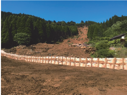
写真-3 火の鳥温泉の大型土のう設置状況
