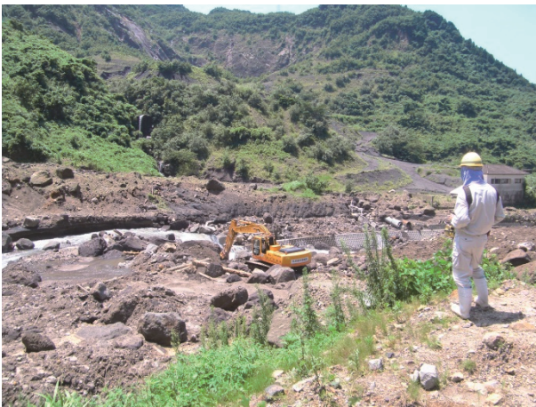
写真-1 土砂災害による河道閉塞現場における緊急作業（H28.7 鹿児島 垂水地区）
