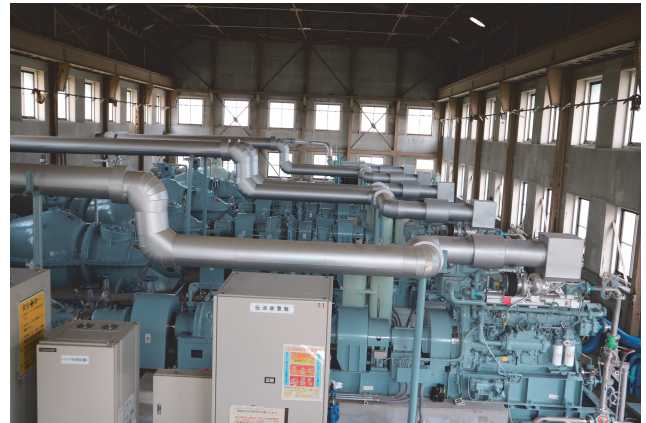
写真-1 ポンプ設備全景
