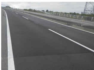
写真-8 舗装全景
