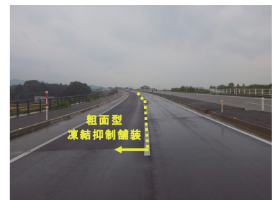
写真-9 降雨時の路面状況
