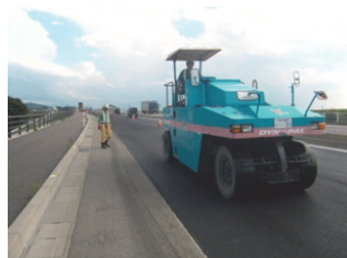
写真-6 仕上げ転圧
