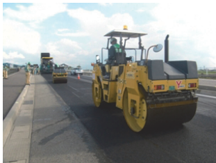
写真-5 初期転圧・二次転圧
