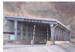
写真-2 鋼製スノーシェッドの例
