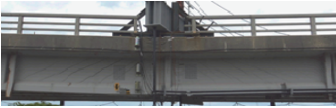
図-6 載荷点付近の破壊性状
