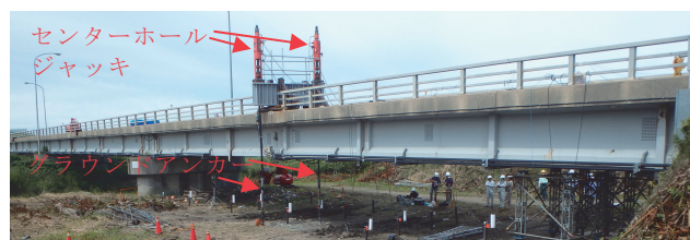
図-4 載荷径間の全景
