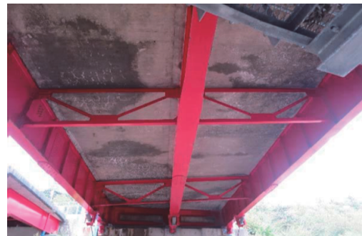
写真-1 床版下面の状況
