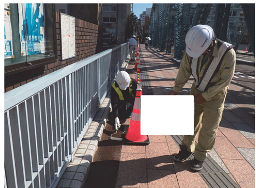
写真-5 浸透吸水防止剤の塗布（犀川大橋）
