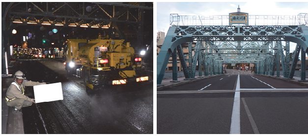
写真-6 防水層の設置（犀川大橋）
