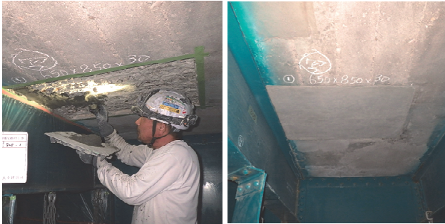
写真-7 断面修復（犀川大橋）
