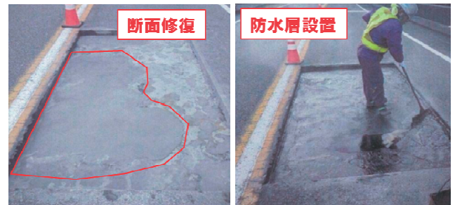
写真-9 断面修復及び防水層設置（大岩橋）
