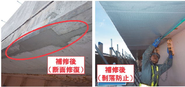
写真-2 断面修復及び剥落防止（高堂高架橋）
