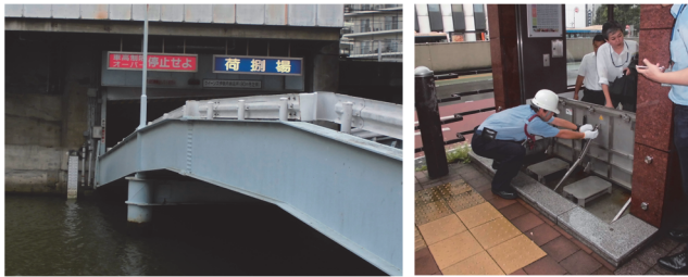
図-5 防潮扉が設置されている荷捌場入口（左）及び地下街出入り口の止水板（右）
