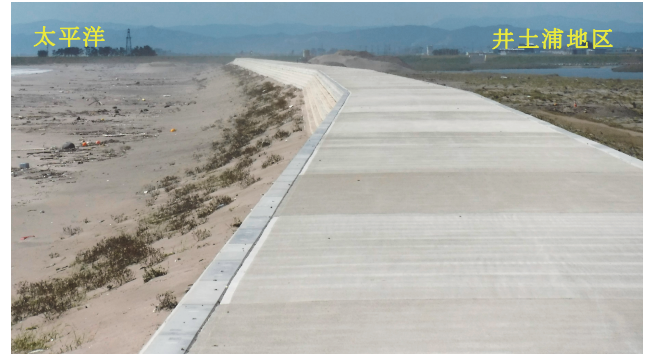
図-11 完成したCSG海岸堤防
