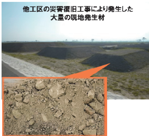
図-5 他工区工事完了による大量の現地発生材
