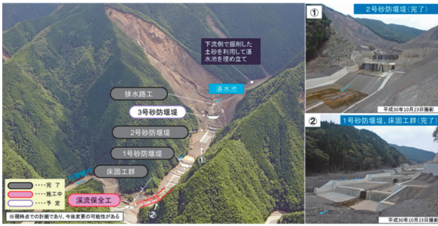
図-7 赤谷地区の現在の状況（平成30年12月時点）
