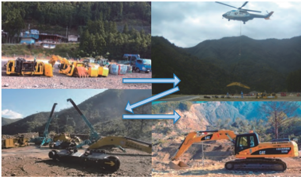
図-11 ヘリによる組み立て式重機搬入
