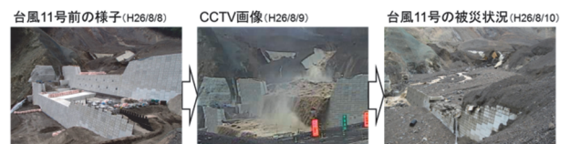
図-6 平成26年台風11号による赤谷地区の被害
