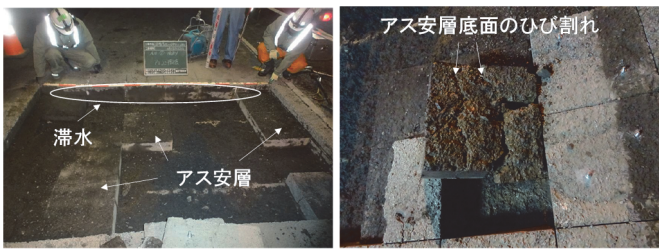
写真-1 工区Ⅰの開削状況
