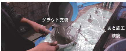
写真-2 せん断補強の施工状況
