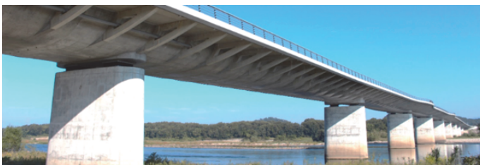
写真-1 各務原大橋 (左岸側より)
