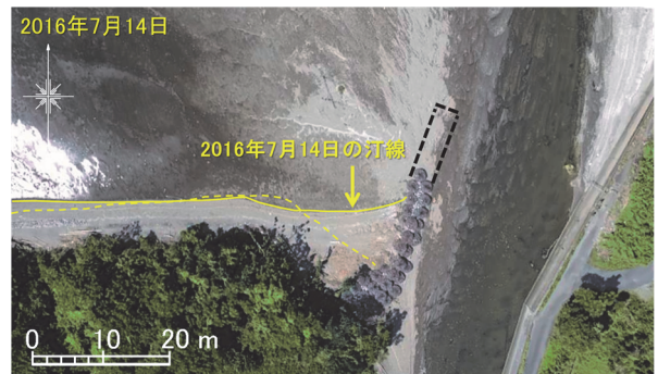
写真-6 施工42日後の状況（2016年7月14日撮影）
