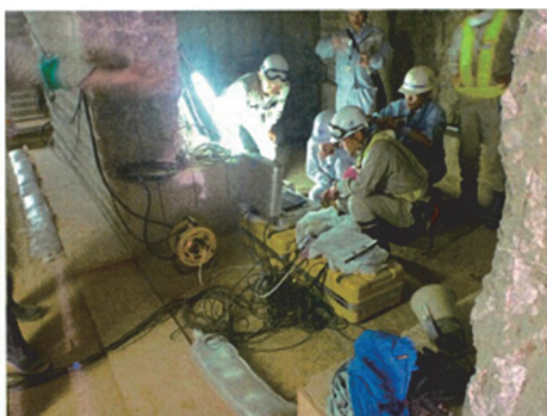
図-8 振動計測状況
