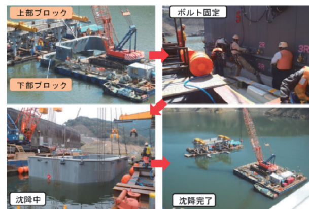
図-12 浮体式仮締切水上組立状況
