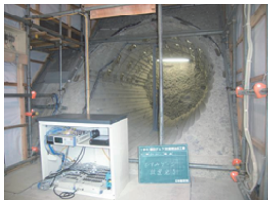
図-7 堤体削孔実証実験
