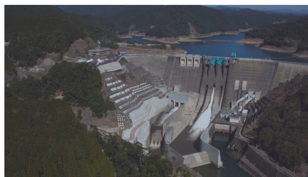
図-13 鶴田ダム再開発事業完成状況
