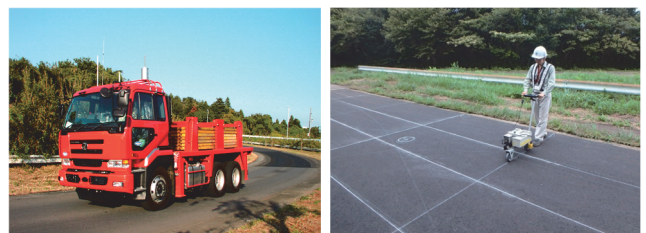
写真-10 荷重車による促進载荷状況
