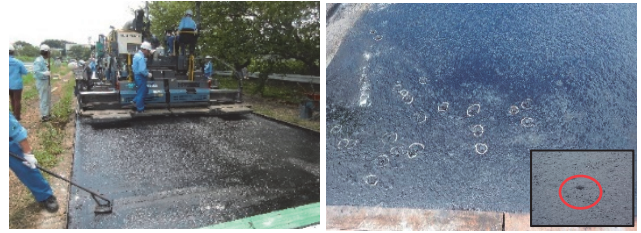
写真-4 開発グース施工状況
