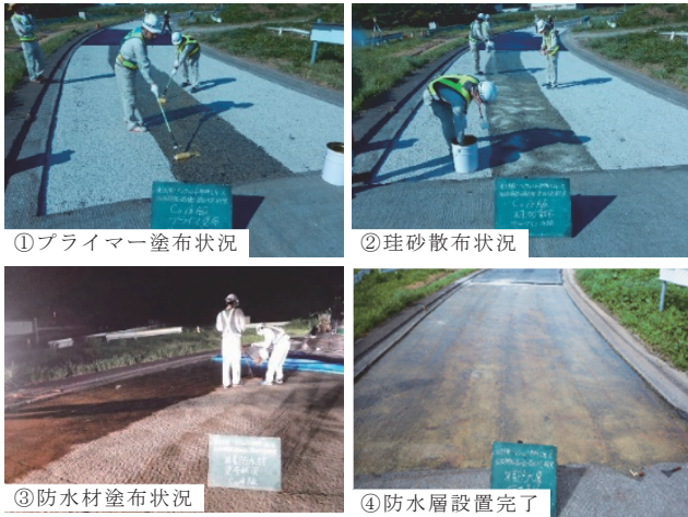
写真-6 開発防水層施工状況
