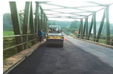
写真-7 表層工(密粒度アスファルト混合物)
