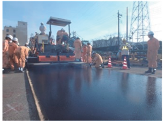
写真-3 アスブトンを用いたグースアスファルト混合物の施工性の確認
