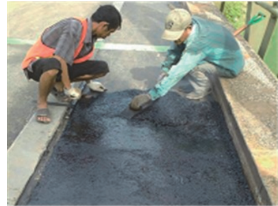
写真-6 アスプトングースアスファルトの舗設
