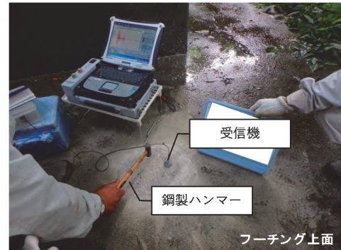
写真-1 高周波衝撃弾性波法による調査例
