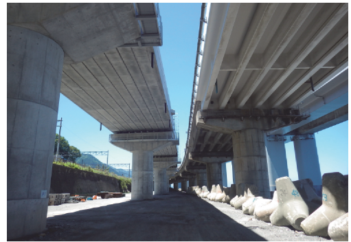
写真-4 架替え状況 (左側からえちごトキめき鉄道、架替橋、旧橋、高速道)
