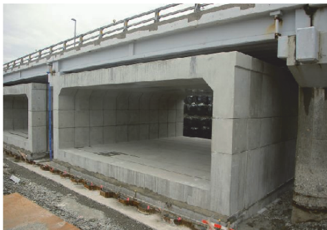
写真-2 両鬼橋施工状
