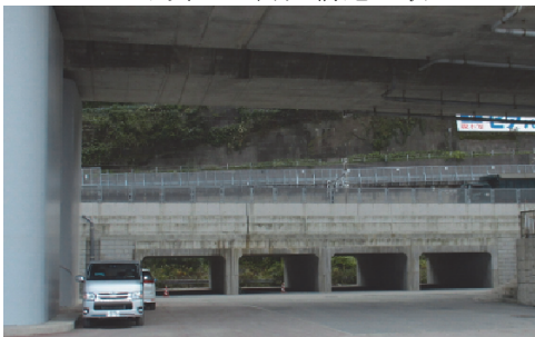
写真-3 歌高架橋Box区間(奥側、手前は高速道) 橋長 130100
