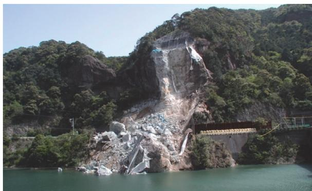
写真-1 ゆるみ岩盤の崩壊
