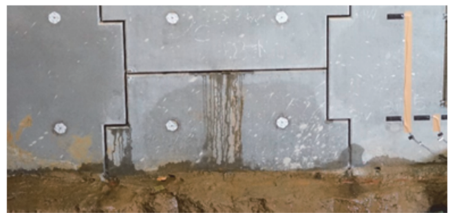
写真-3 CASE1での目地部からの排水状況 (最下段)
