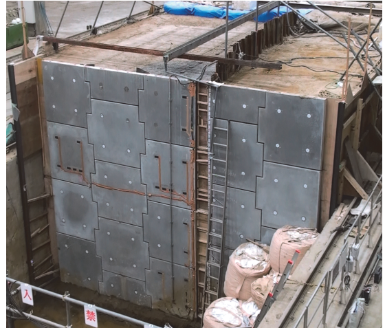
写真-1 補強土実大模型
