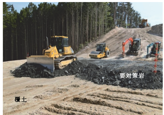
写真-1 区分Ⅱ盛土施工状況（浪板地区）
