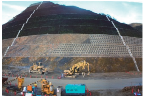
写真-2 江住地区の法面
