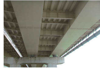
写真-1 鋼床版を有する箱桁橋の下面
