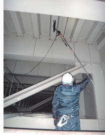
(b) 桁高の高い箱桁内の調査
