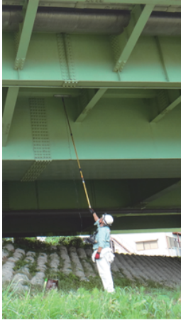
(c) 地上からの調査
