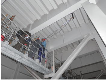
(a) 検査路からの調査
