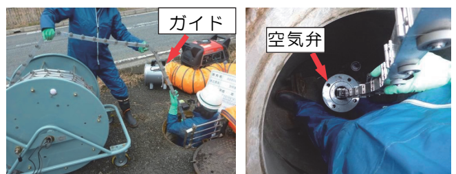
図-6 調査機器の挿入状況
