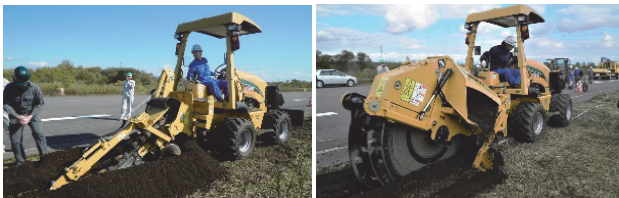
写真-3 トレンチャー掘削状況 左：チェーン式、右：ホイール式
