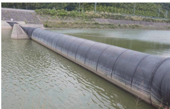
図-1 ゴム引布製起伏堰の外観
