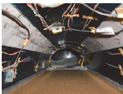
写真-7 補強状況
