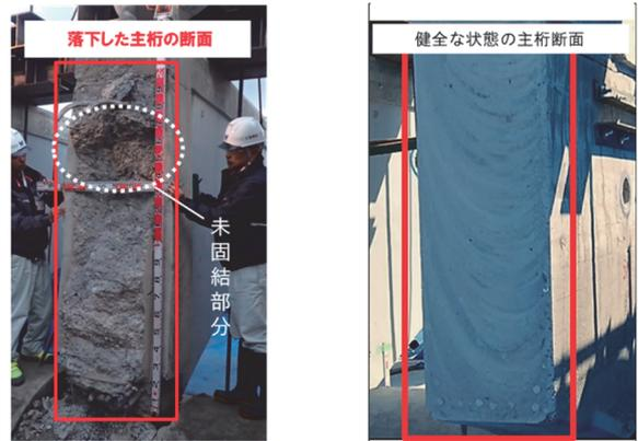
写真-7 落下した主桁と健全な主桁の断面
