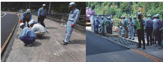
写真-2 RC床版土砂化橋梁の合同調査
