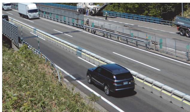
写真-1 据置型車両用防護柵の設置事例
