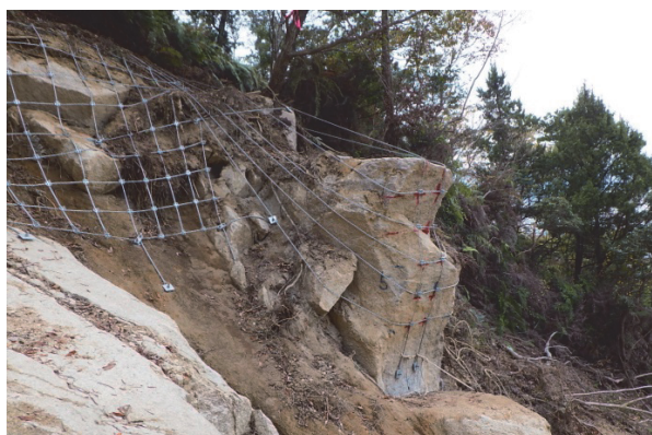
写真-5 落石対策工の設置 (呉市天応地区大屋大川)
