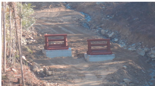
写真-3 土石流制御工による流向制御 (広島市安芸区大元谷川)
