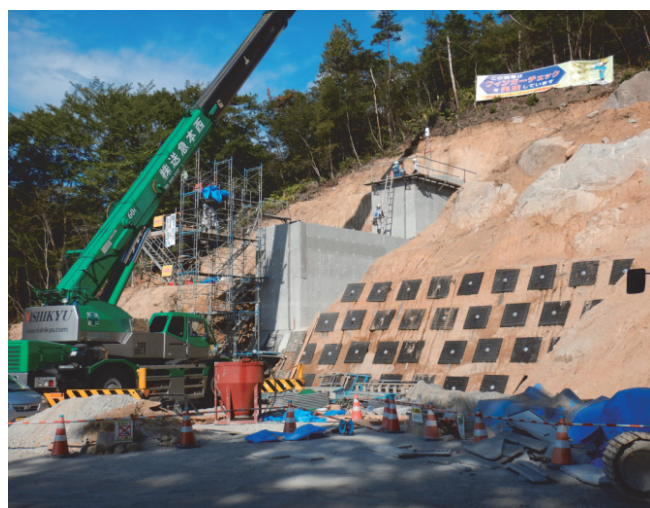
写真-7 砂防堰堤の本体コンクリートの打設 (呉市天応大屋大川)
