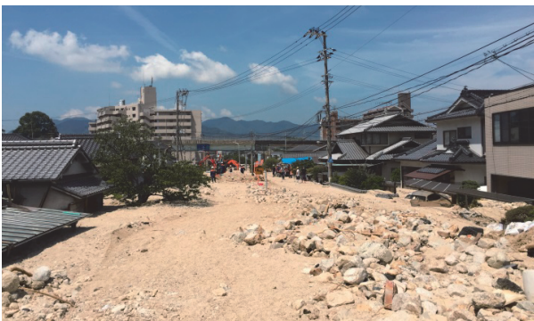
写真-1 坂町総頭川での土砂・洪水氾濫被害
