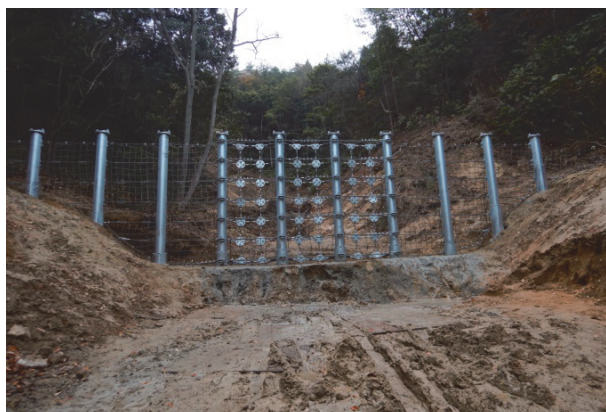
写真-4 杭式土石流・流木捕捉工の設置 (呉市天応地区背戸の川)
