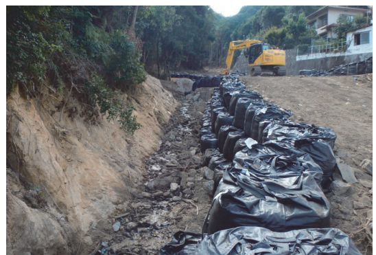
写真-2 大型土囊による水路確保 (広島市東区寺条川右支)
