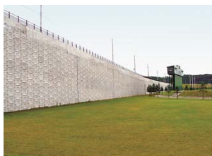
写真-1 多数アンカー工法
