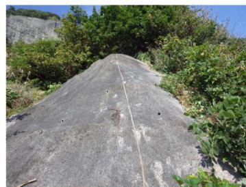
写真① 既設ロープで天端へ
