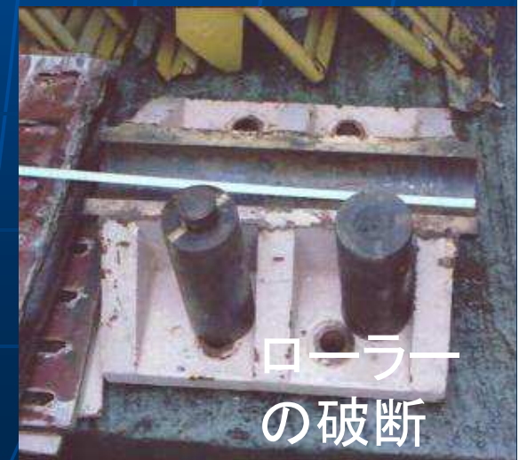
脊座の被害(縁端距離不足)
