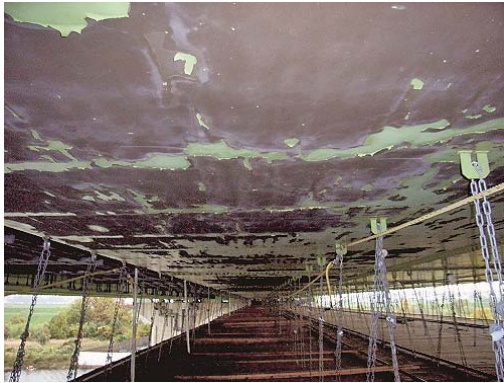
写真-2 塗膜はがれの状況
