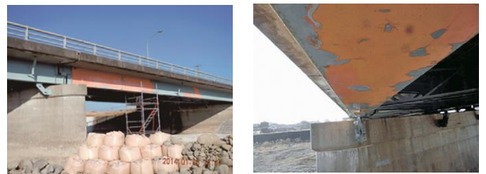
写真-3 塗膜のはく離の状況（A橋）
