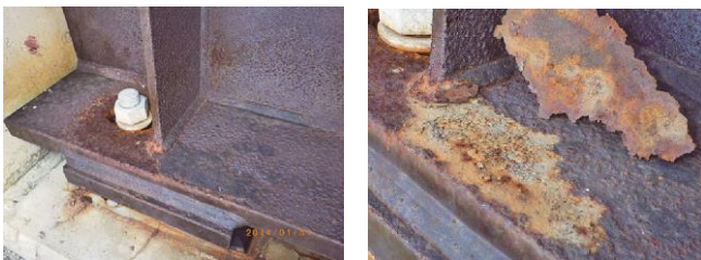
写真-5 桁端部の損傷状況（C橋）
