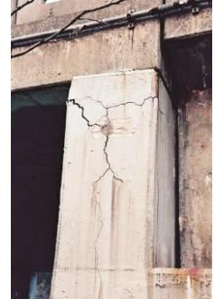
写真-1 橋脚のASR損傷の例
