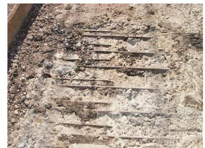
写真-2 床版上側主筋の露出状況
