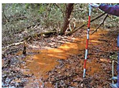
写真-2 盛土法尻部の湧水例
