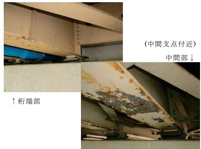
写真-3 D橋の桁端部と中間部外観
