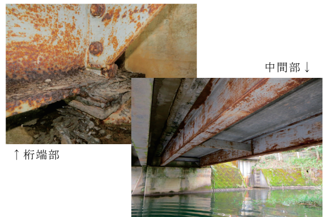
写真-5 I橋の桁端部と中間部外観
