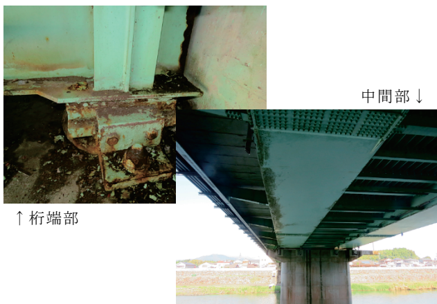
写真-4 M橋の桁端部と中間部外観
