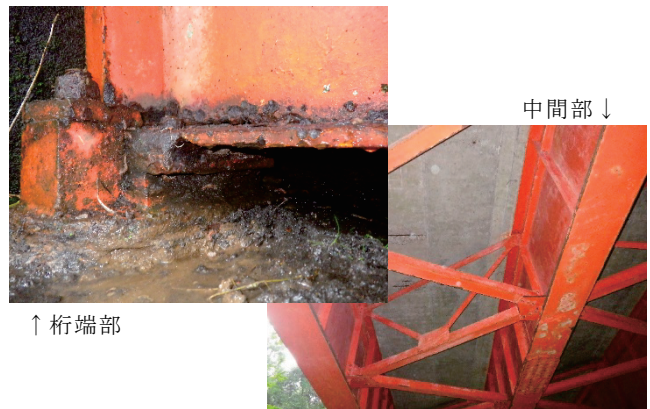
写真-1 T橋の桁端部と中間部外観
