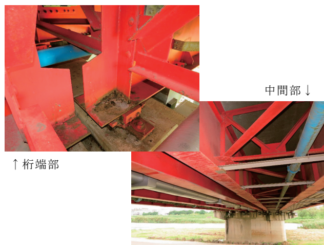
写真-2 N橋の桁端部と中間部外観
