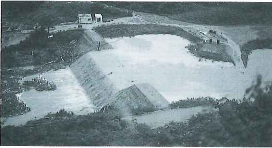
写真-1 越流状況 (C 構造物)
