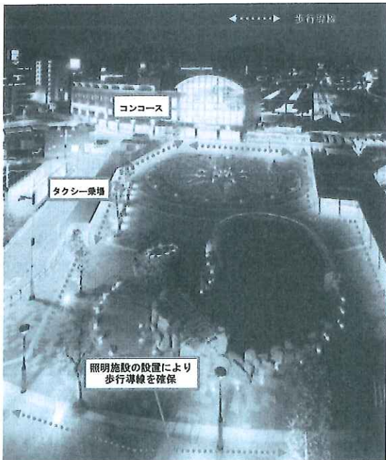
写真-1 照明施設の明るさによる歩行導線の設計例 (高松駅前広場)
