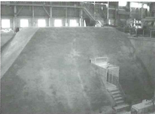
写真-1 実大実験用盛土(堤体模型)
